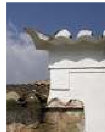
Beirado composto e remate de fachada. Ribeirinha, Tavira.
