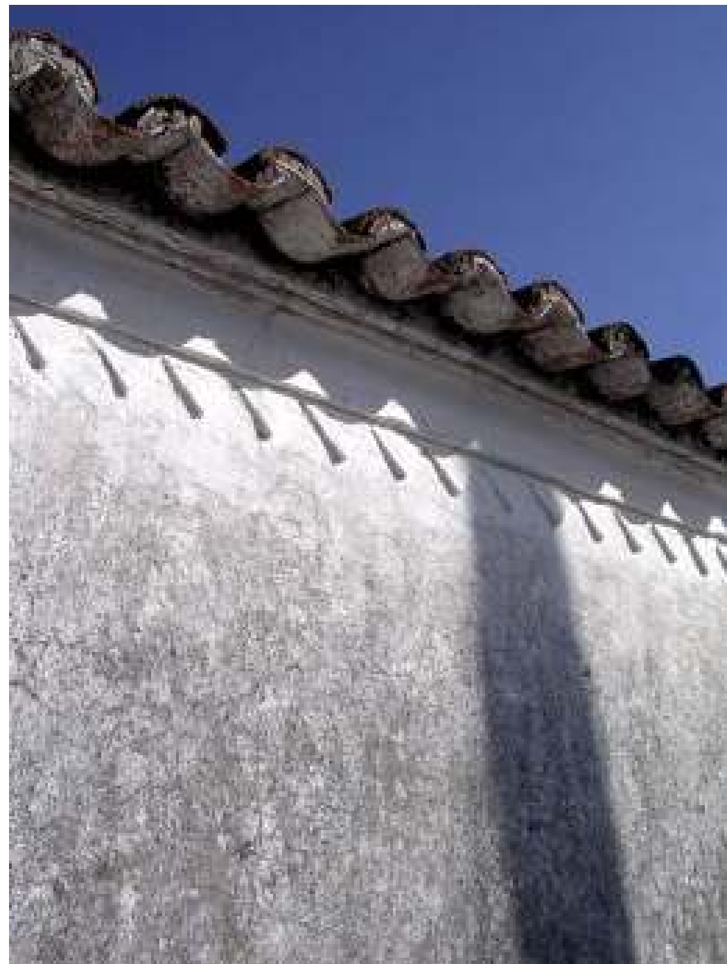
Beirado composto. Malfrades, Alcoutim. fotografia GTAA Sotavento
