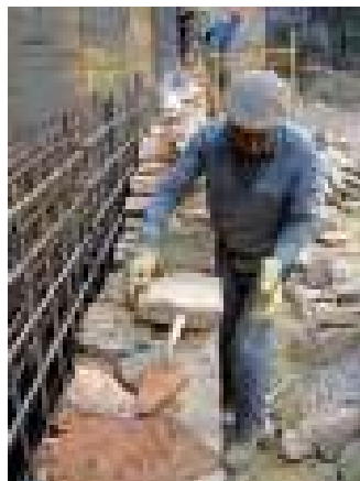
figura 342 Construção do muro de suporte misto de alvenaria de xisto e betão armado Alexandre Miguel Costa
