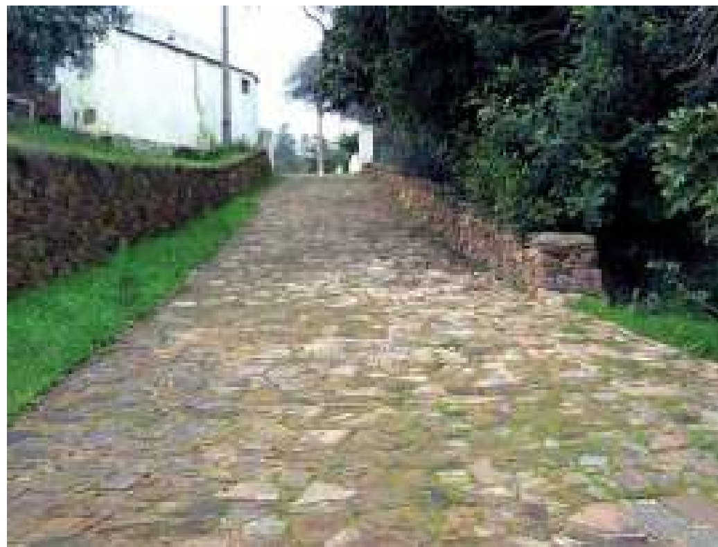
figura 350 Calçada e muros de xisto no percurso a sul/poente, após intervenção fGTAA
