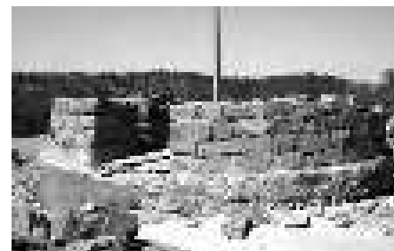
figura 215 Execução da parede em alvenaria de xisto Sílvia Bento
