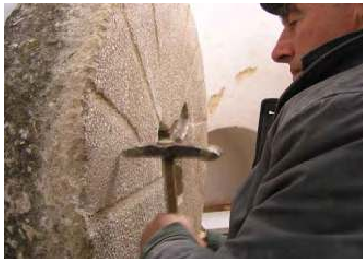
figura 8 Cachopo, Reconstrução do Moinho Branco: picagem da mó f S M
