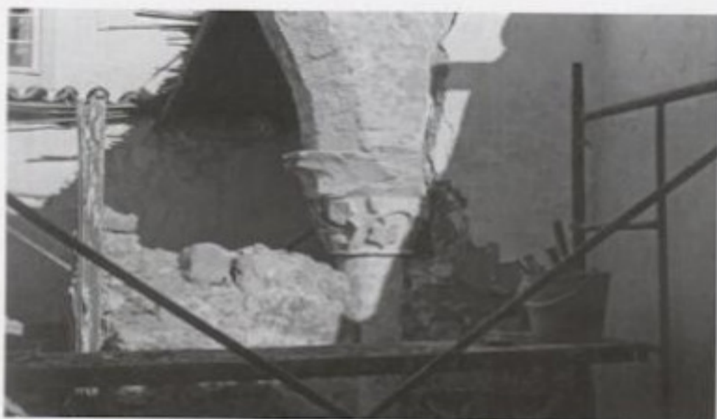
Ilustração 3 - Detalhe da demolição
