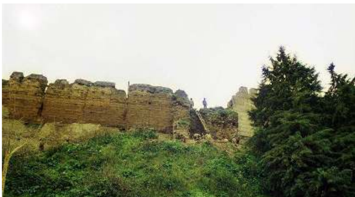
Fig. 67. Pano de muralha em taipa visível nos anos 80 que se seguia a partir da torre 11 (imagem do inventário da D.G.E.M.N.: INV/DGEMN).
