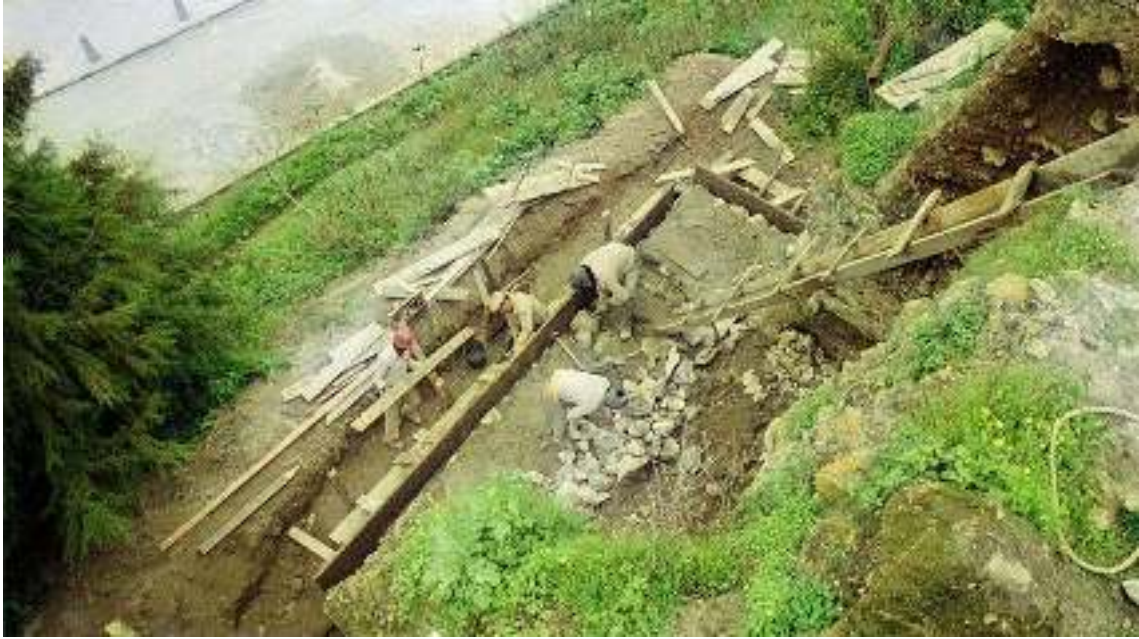
Fig. 64. Reconstrução da torre 11 da medina em 1983 (imagem do inventário da D.G.E.M.N.: INV/DGEMN).
