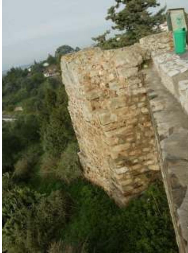
Fig. 108. Paramento construtivo da torre 29 onde se observa várias fases construtivas.
