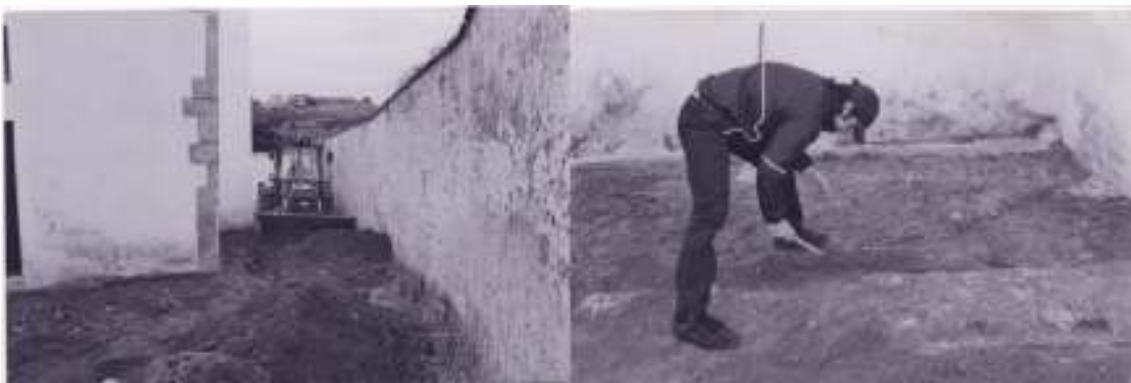
Fig. 135. Realização de obras junto da Igreja de Santa Maria do Castelo, onde se vê na fotografia da direita o muro de um edifício pré-existente (fotografias cedidas pelo Gabinete de Arqueologia da Câmara Municipal de Alcácer do Sal).
