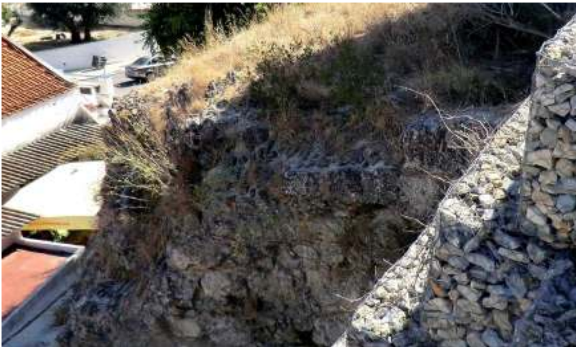
Fig. 109. Paramento construtivo da plataforma da torre 15.
