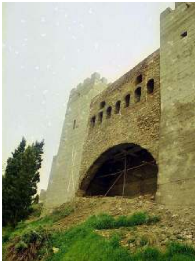
Fig. 45. Arco abatido durante as intervenções de restauro da DGEMN (imagem do inventário da D.G.E.M.N.: INV/DGEMN).
