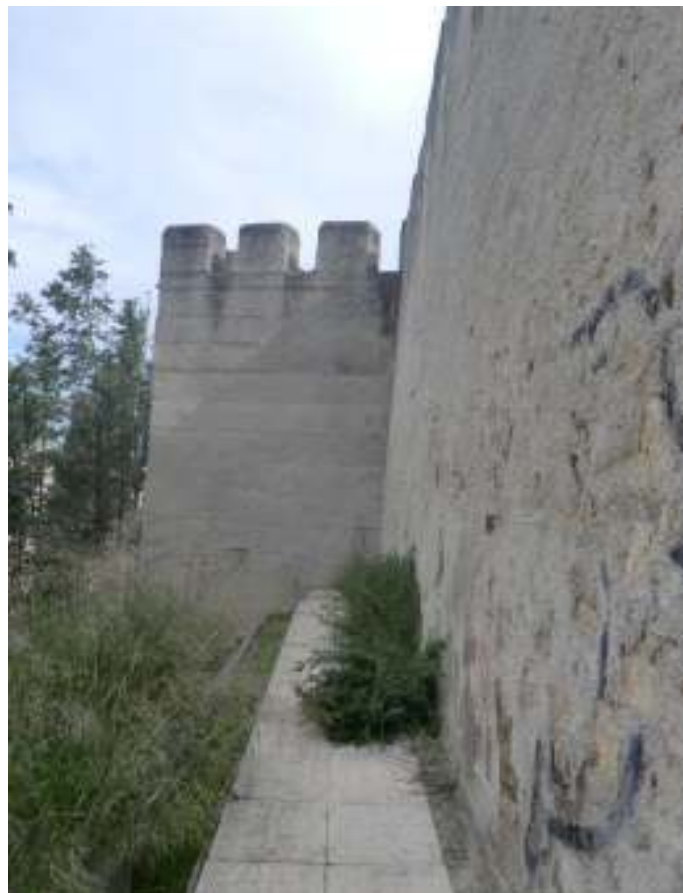
Fig. 51. Torre 8 ao nível do adarve.
