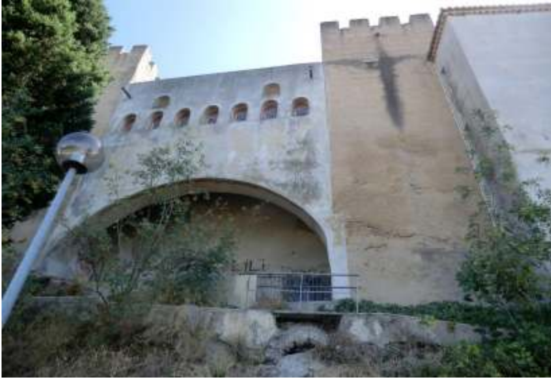
Fig. 44. Passadiço que estabelece a ligação entre a torre 6 e 7 da alcáçova e em baixo é visível a estrutura circular para o escoamento de águas.
