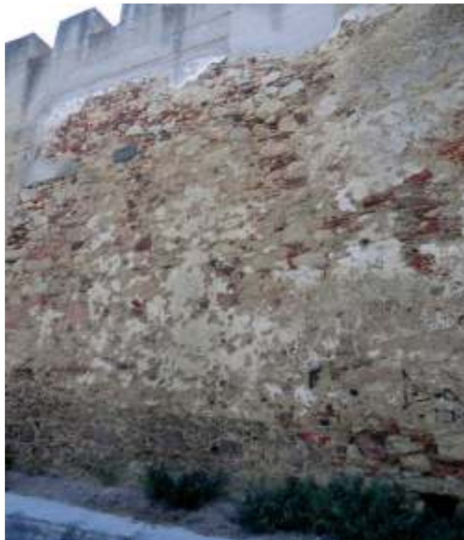
Fig. 63. Pano de muralha que se segue a partir da torre 10 edificado em alvenaria de pedra e tijolo, sendo visível sistema de escoamento de águas.
