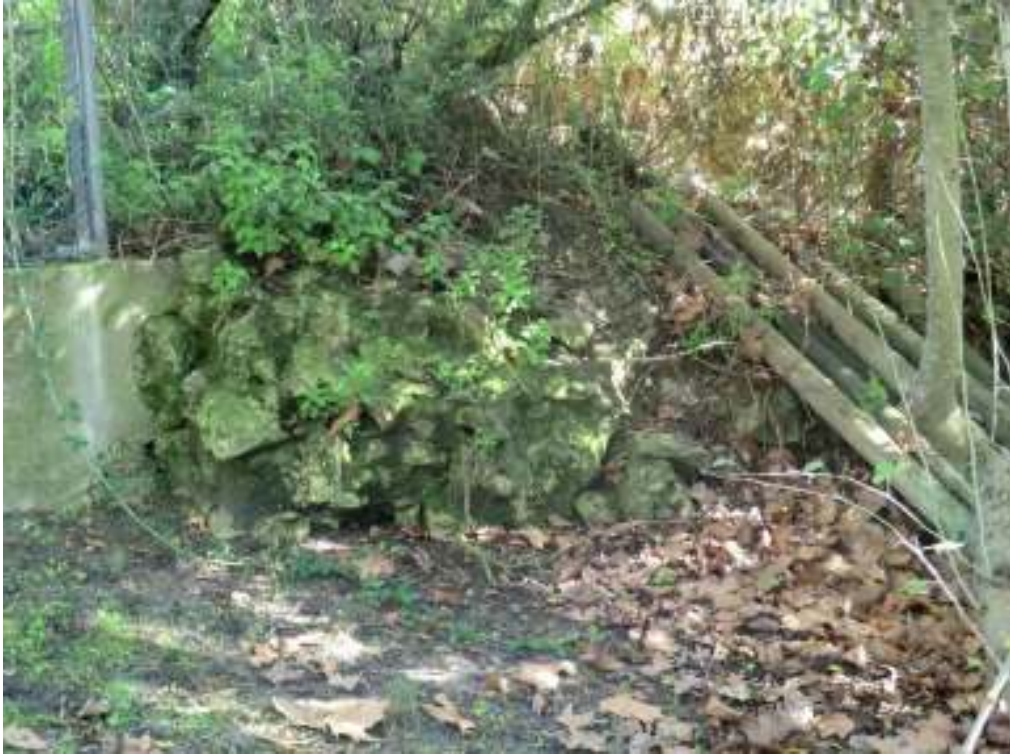
Fig. 71. Vestígios da torre que defendia a Porta Nova.
