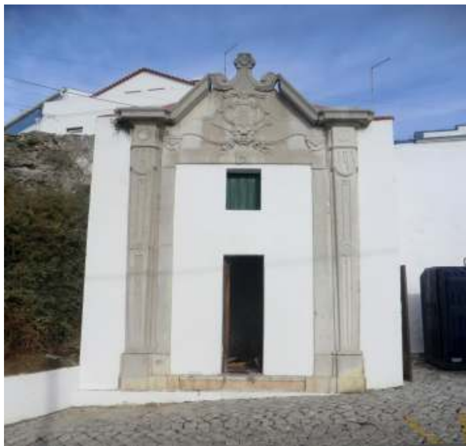
Fig. 87. Ermida da Nossa Senhora da Conceição da Porta de Ferro.
