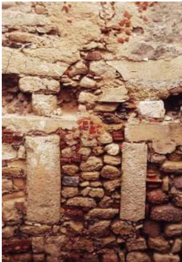
Fig. 27. Porta de arco ultrapassado entaipada (antes da construção da pousada) integrando a face poente da torre (imagem cedida pelo Gabinete de Arqueologia da Câmara Municipal de Alcácer do Sal).
