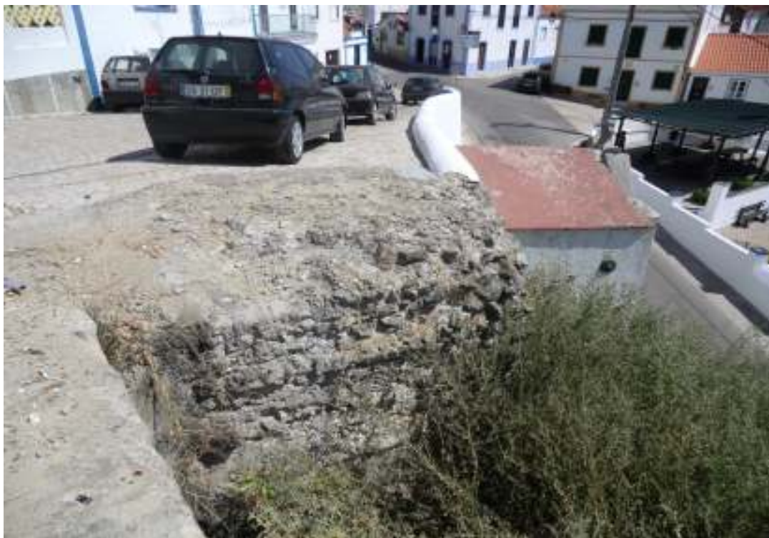
Fig. 88. Passadiço de acesso à torre 20.
