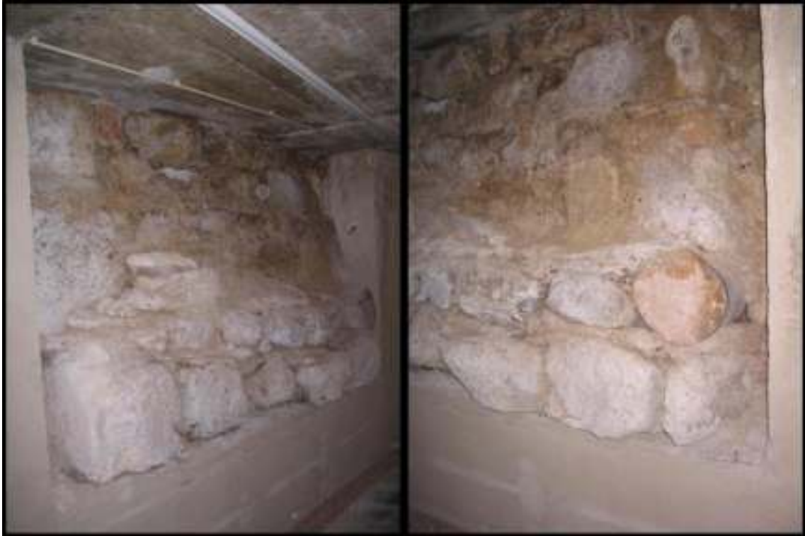
Fig. 32. Fundação da torre 3 da alcáçova encontrada durante as intervenções arqueológicas realizadas entre 1995 e 1997, sendo possível observar uma coluna romana reutilizada no paramento construtivo.
