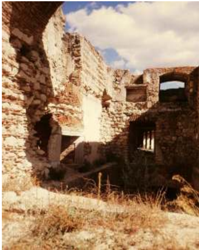
Fig. 23. Aparelho construtivo do interior da face Este da torre 3 (imagem cedida pelo Gabinete de Arqueologia da Câmara Municipal de Alcácer do Sal).
