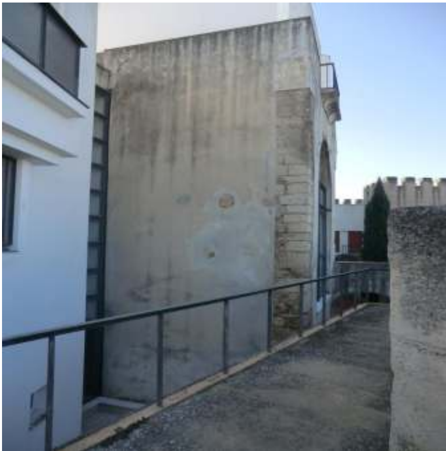
Fig. 25. Torre 3 da alcáçova na atualidade integrada no edifício da pousada.
