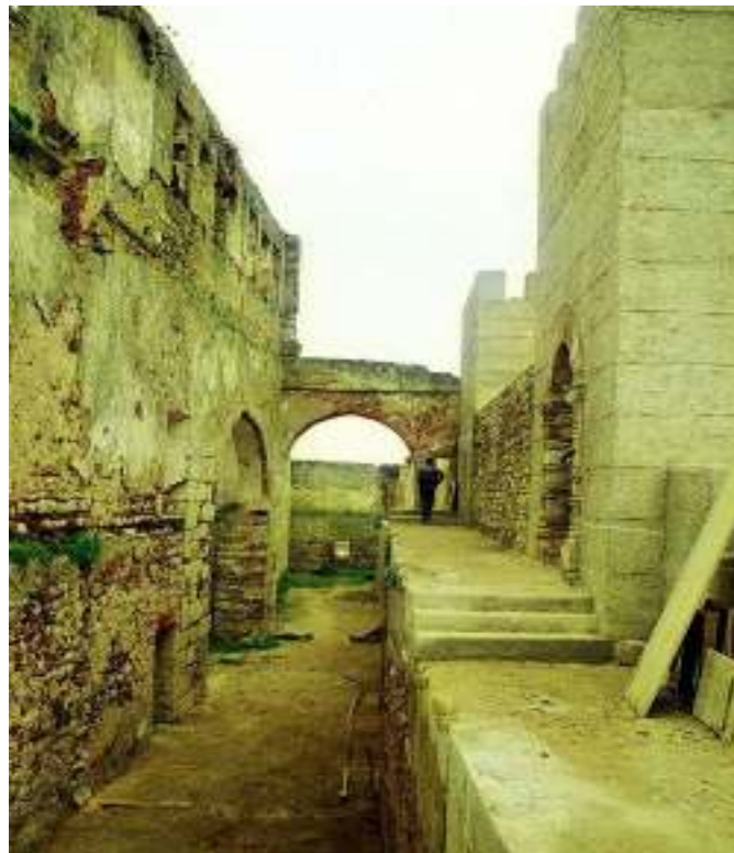
Fig. 33. À esquerda torre 4 e à direita torre 6 da alcáçova, encontrando-se ambas ligadas por um passadiço (imagem do inventário da D.G.E.M.N.: INV/DGEMN).
