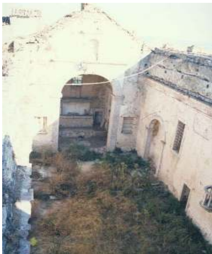
Fig. 16. Torre 1 da alcáçova adaptada a capela-mor e sacristia da igreja do convento de Aracoeli (imagem do inventário da D.G.E.M.N.: INV/DGEMN).
