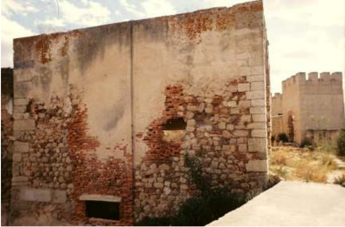
Fig. 22. Torre 3 da alcáçova edificada em pedra e tijolo sendo reforçada nos cunhais com pedras de dimensão (fotografia cedida pelo Gabinete de Arqueologia da Câmara Municipal de Alcácer do Sal).
