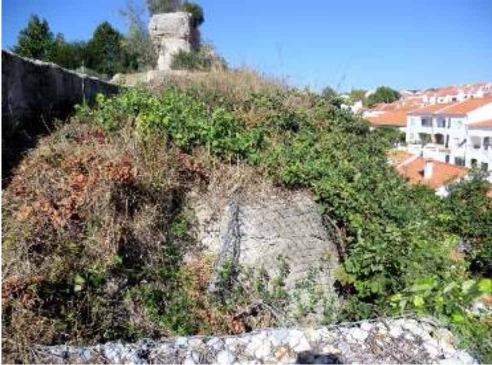
Fig. 73. Vestígios da torre 14.
