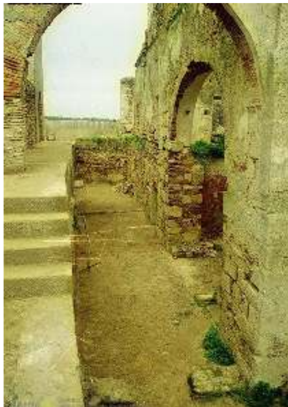
Fig. 41. Arco que arranca da torre 4 em direção à torre 6, sendo visível no chão o vão de entrada de uma porta (imagem do inventário da D.G.E.M.N.: INV/DGEMN).
