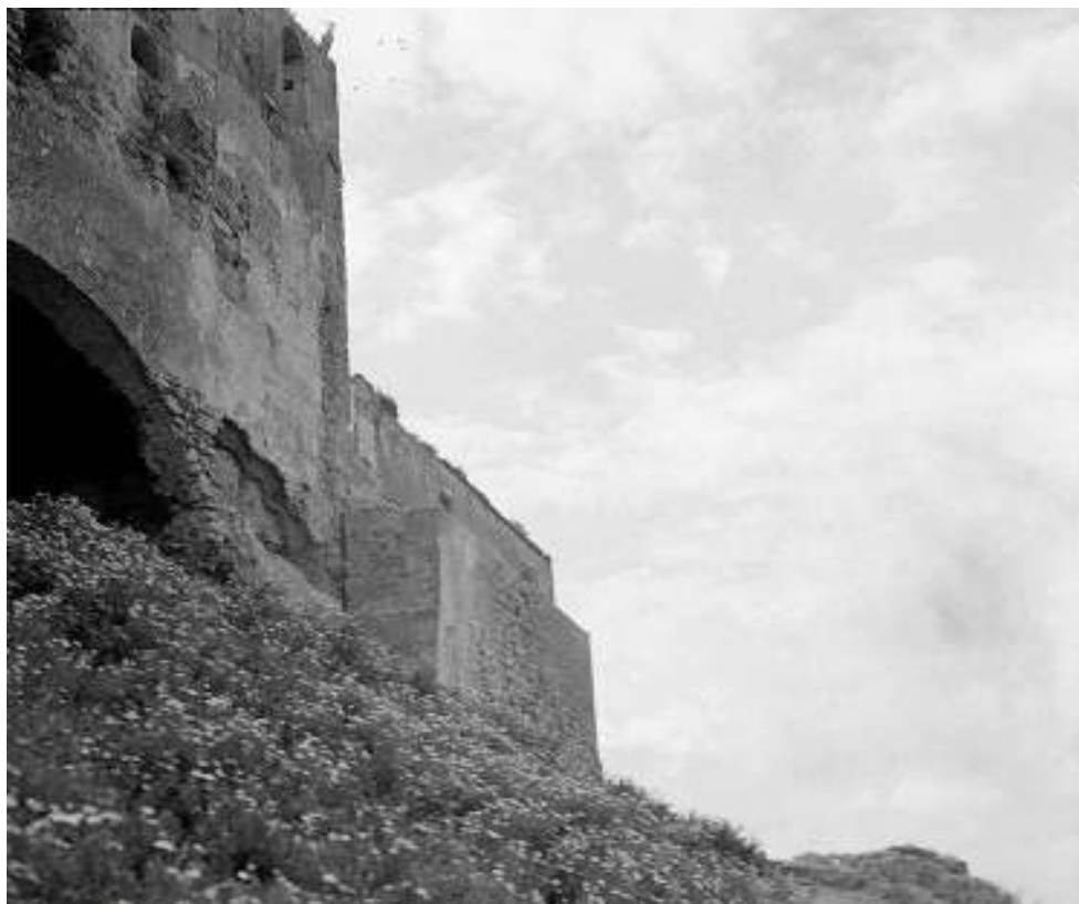
Fig. 36. À direita na foto a base da torre 5 da alcáçova e no lado esquerdo a torre 6, em 1959, antes das intervenções da DGEMN no setor Oeste do castelo (imagem do inventário da D.G.E.M.N.: INV/DGEMN).
