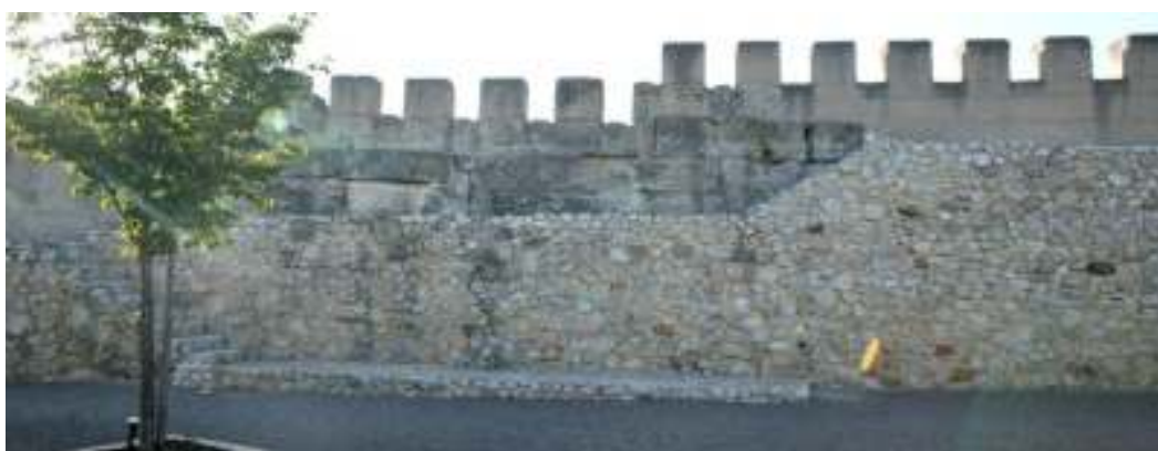
Fig.112. Paramento construtivo do adarve da muralha no setor norte.
