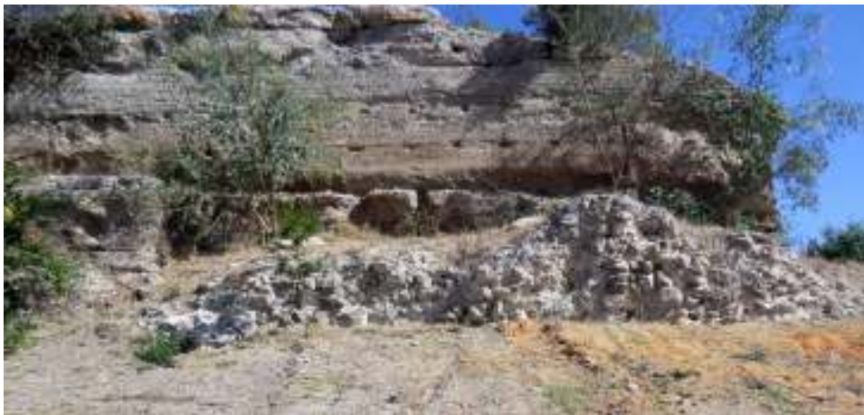
Fig. 72. Vestígios da torre 13.
