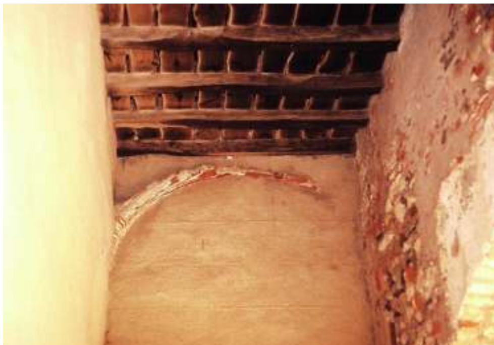
Fig. 46. Porta entaipada na face Este da torre (imagem cedida pelo Gabinete de Arqueologia da Câmara Municipal de Alcácer do Sal).
