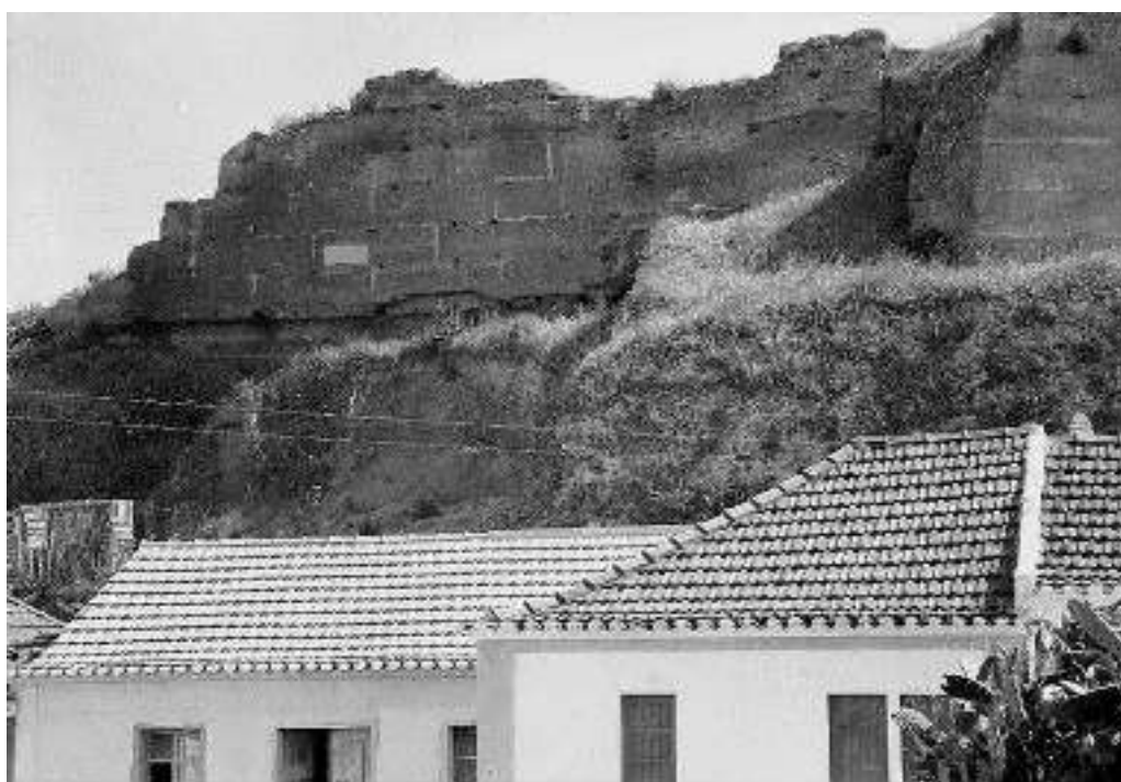
Fig. 82. Pano de muralha em taipa visível nos anos 60 que se seguia a partir da torre 15 (imagem do inventário D.G.E.M.N.: INV/DGEMN).
