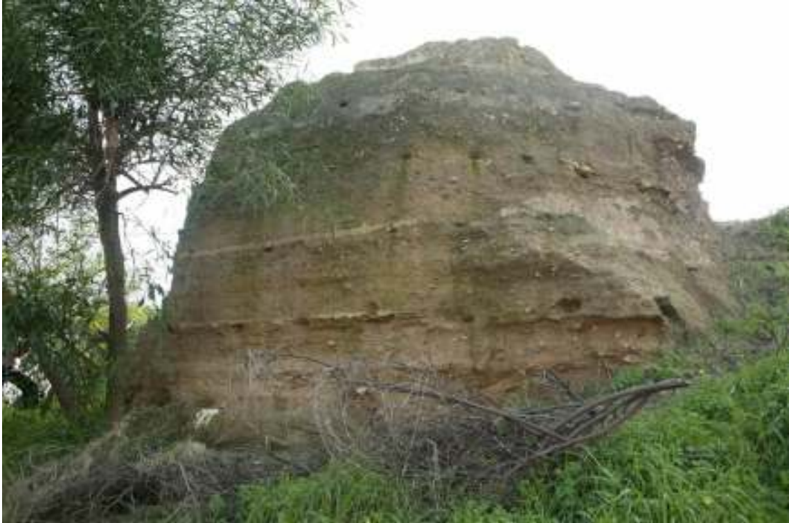
Fig. 83. Torre octogonal em ruínas.
