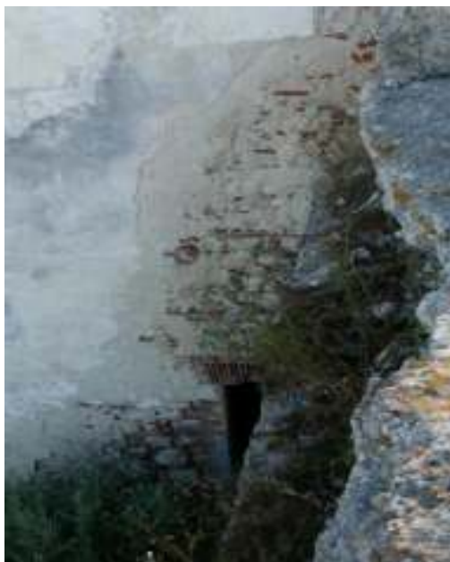
Fig. 110. Paramento construtivo da Torre do Relógio (torre 23).
