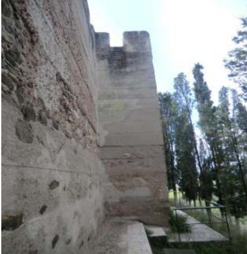
Fig. 52. Pano de muralha que se segue a partir da torre 8.
