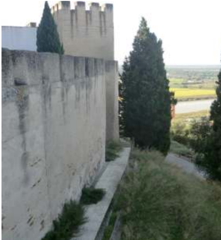
Fig. 50. Pano de muralha que se segue a partir da torre 7.
