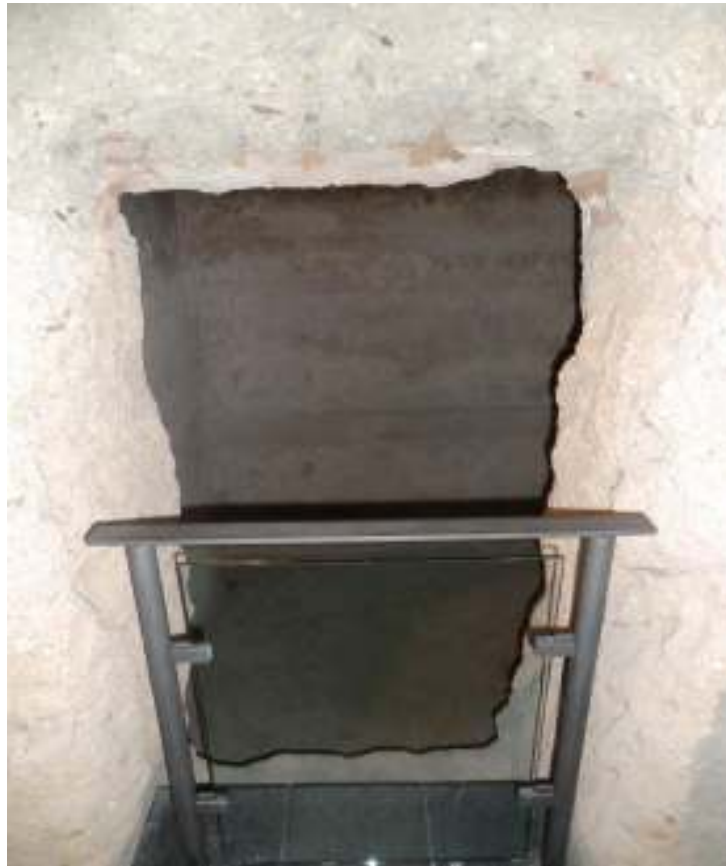
Fig. 124. Cisterna do Convento.
