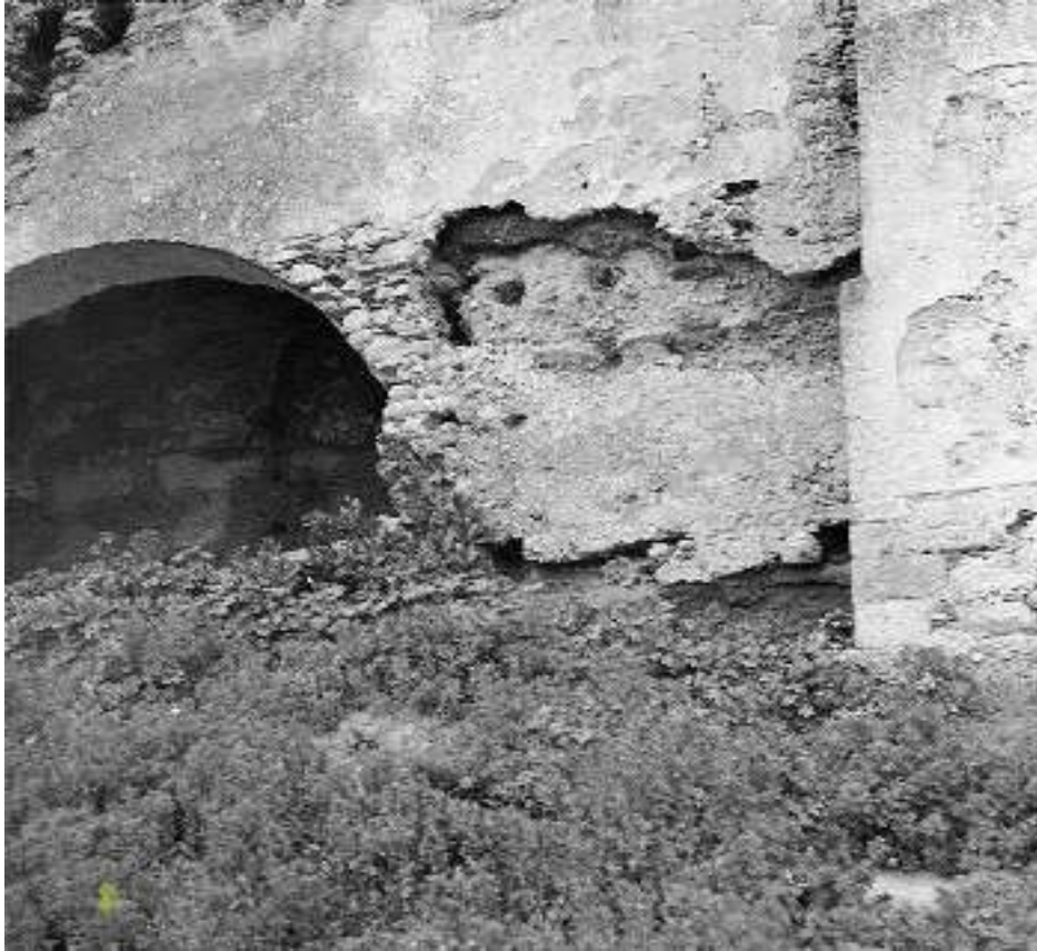
Fig. 40. Interior da torre 6 em taipa antes dos restauros efetuados pela DGEMN (imagem do inventário da D.G.E.M.N.: INV/DGEMN).
