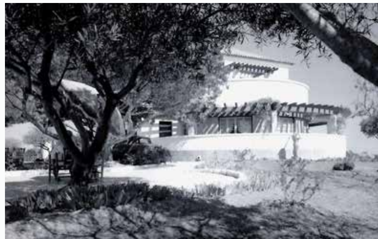
A fachada poente da Pousada de S. Braz d'Alportel com a varanda em arco da sala comum de onde se abarcavam as melhores vistas. Foto de H. Novais.
