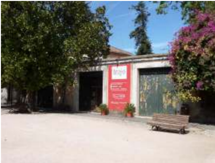
a) Aspecto exterior
