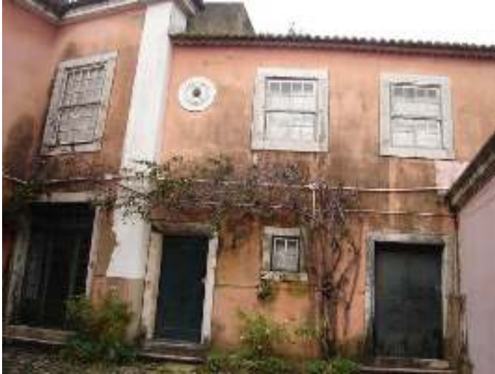
a) Exterior da Casa do Caseiro. (Fonte: fotografia pessoal)
