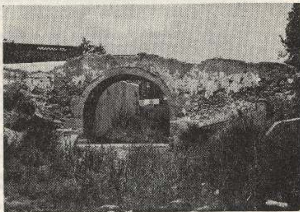
A Ponte Velha de Quelfes, no seu estado actual.
