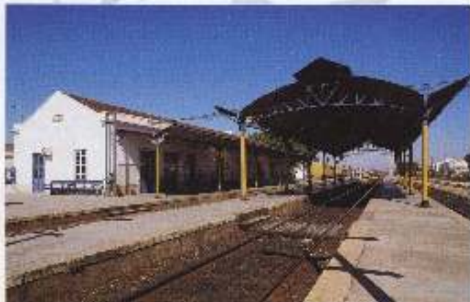
Fig. 21 - Nó ferroviário e gare dos inícios do século.
