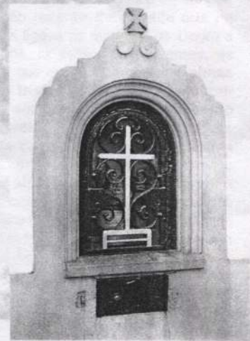
L – Capela de S. Roque da Lameira
