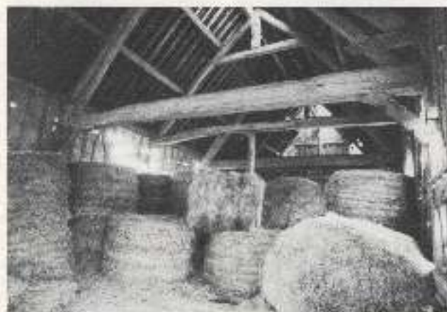
16 - La grange B en 1964, nord-sud, vue depuis l'extérieur, halles de bois destinées à l'inventaire des veaux. (cf. ATP 4, 1964).
