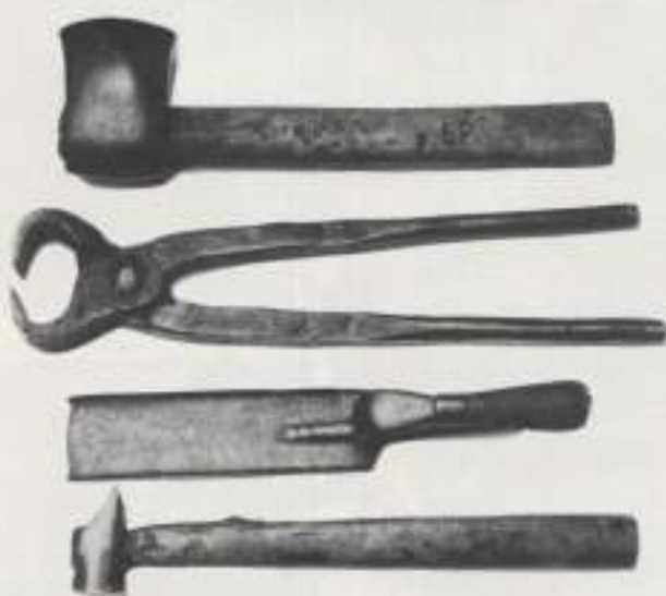
Outils de maréchal-ferrant, de haut en bas : ferretier, tricolese, boutoir et brochoir. Hautes-Alpes, Saint-Véran, 19 e siècle (cf. ATP, ph. C. Jey)
